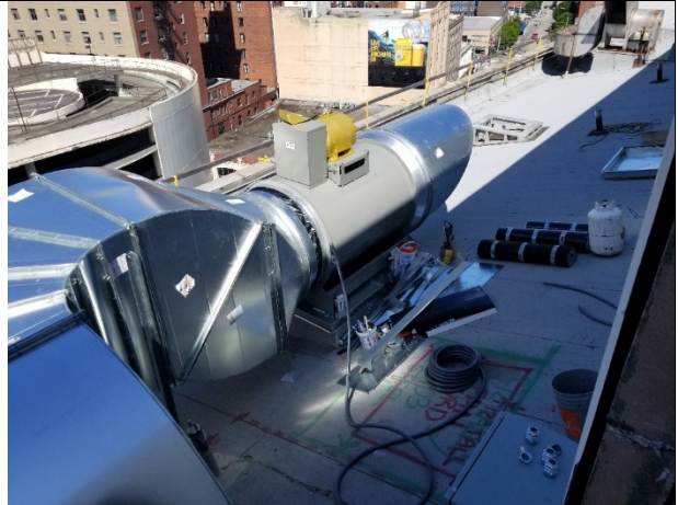
Elevator 9 & 10 Pressure Fan
