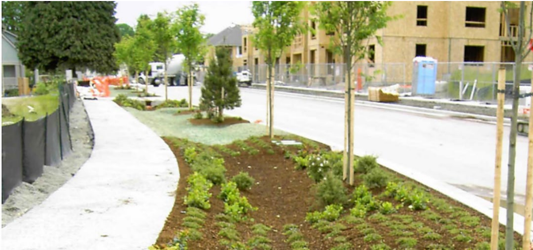
Hệ thống thoát nước tự nhiên mới được thi công.
