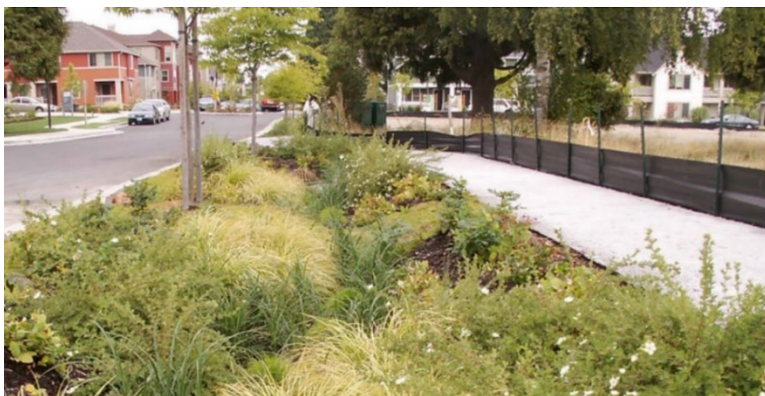
Hệ thống thoát nước tự nhiên đã hoàn thiện.
