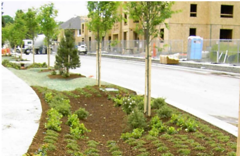
Hệ thống thoát nước tự nhiên mới được thi công.
