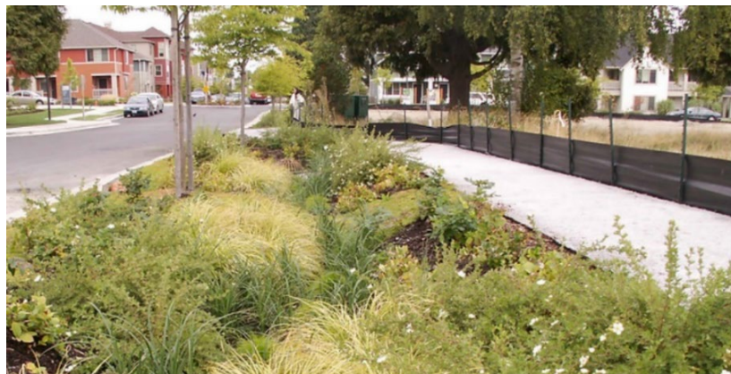
Un sistema de drenaje natural terminado.
