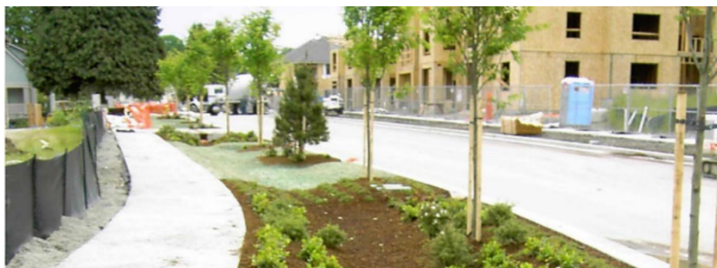
Hệ thống thoát nước tự nhiên mới được thi công.
