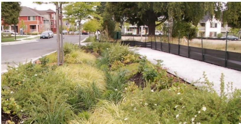
Un sistema de drenaje natural terminado.
