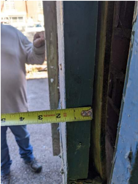
Fig 2.0g: (E) Door Thickness
