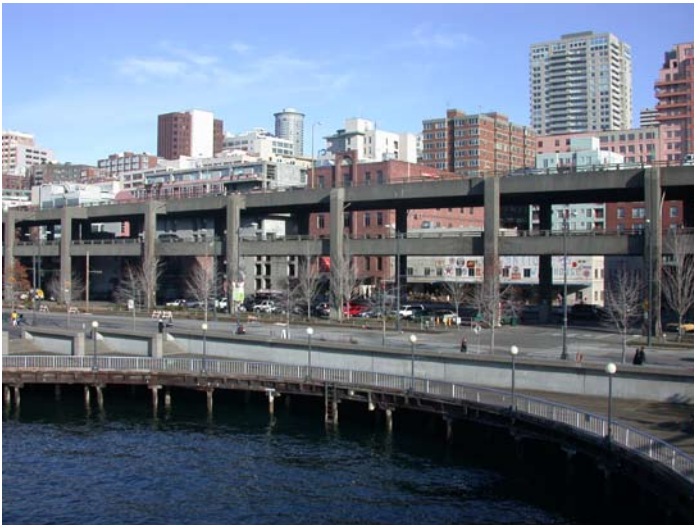
Alaskan Way Viaduct
