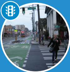
經改善的十字路口，設有新的交通信號燈；為行人和騎單車者提供的更安全的人行橫道
