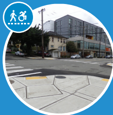
升級改造的人行橫道，以及為殘疾人提供的無障礙路緣坡道
