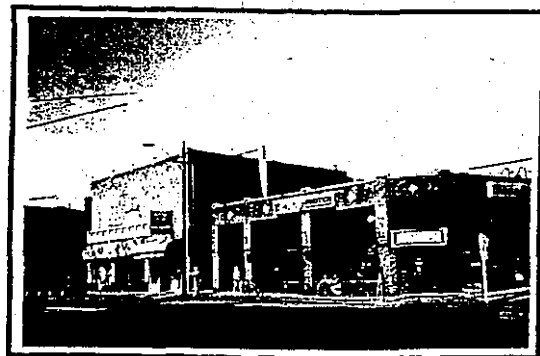
TB-8 Masonic Building 7210 E. Green Lake Dr. N.
