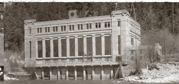
Como respuesta a las crecientes demandas de energía, se construyó un anexo de 100 pies (30 metros) en el edificio neoclásico reforzado de hormigón y acero en 1949. Gorge High Dam, ubicada varias millas río arriba de la central eléctrica, se construyó entre 1955 y 1961 y reemplazó a las otras dos en la misma ubicación. Deténgase en la galería de visitantes para ver la planta y los generadores.
