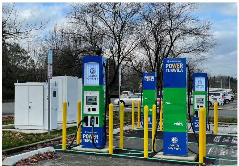
Estaciones de carga de EV que Seattle City Light posee y opera en Tukwila, Wash.
