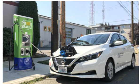
Estación de carga rápida de EV de Seattle City Light, ubicada en el vecindario de Madison-Miller
